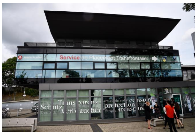
Budynek usługi transgranicznego pośrednictwa pracy w Kehl - © Stadler RGE
