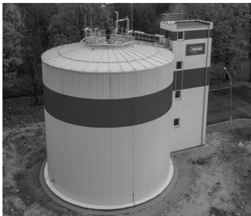
Rysunek 6. Budowa komory fermentacyjnej
